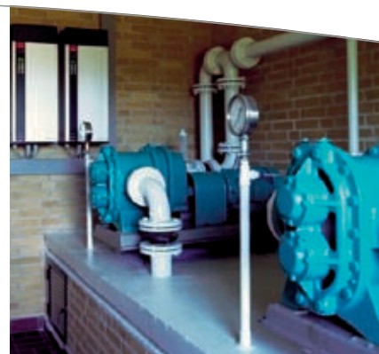
Flexibel kompressordrift även över nominellt varvtal och högt startmoment vid igångsättning möjliggör bättre reglering och stora besparingar.
